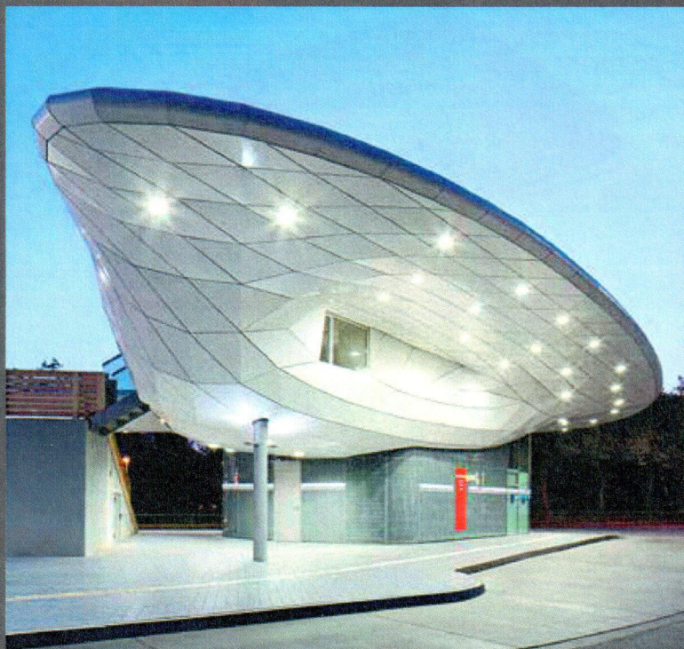
Zawieszone skrzydło dachu dworca autobusowego Hamburg Poppenbützel jest wykonane z paneli ALUCOBOND® PLUS koloru białego. | Zdjęcie: archimages
